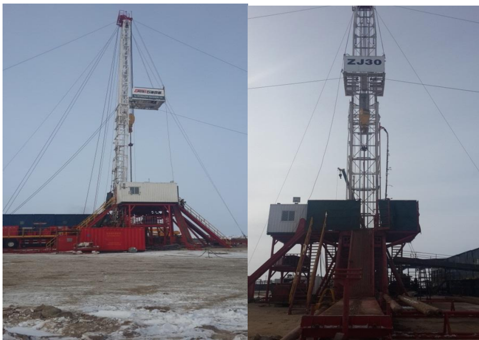
Рисунок 1. Опасные производственные объекты м/р Кумколь
