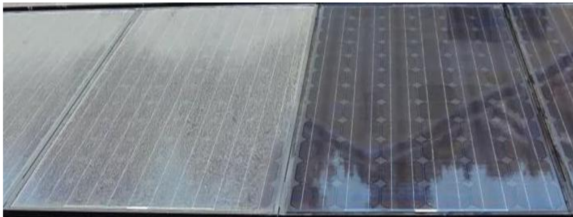
Сурет-4 Таза және ластанған Күн панельдері
